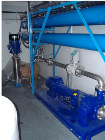
Abb. 7: Druckerhöhungsstation und Membranmodule
